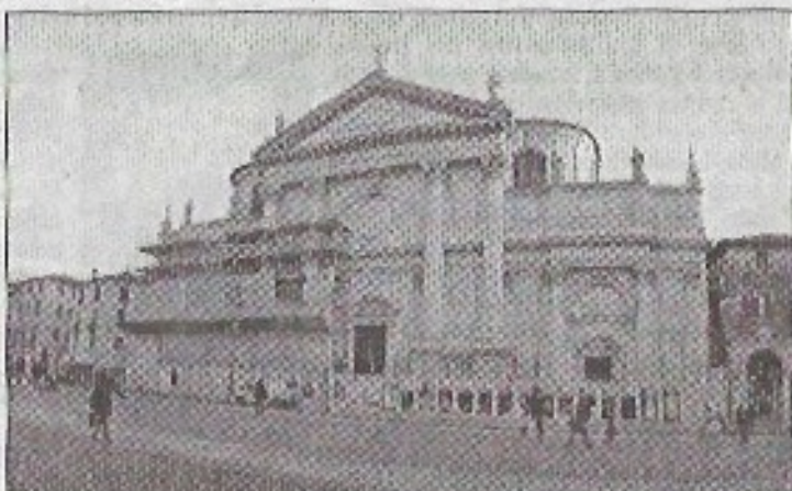
VIA IL CANTIERE Si tolgono le impalcature alla chiesa di San Giovanni.
